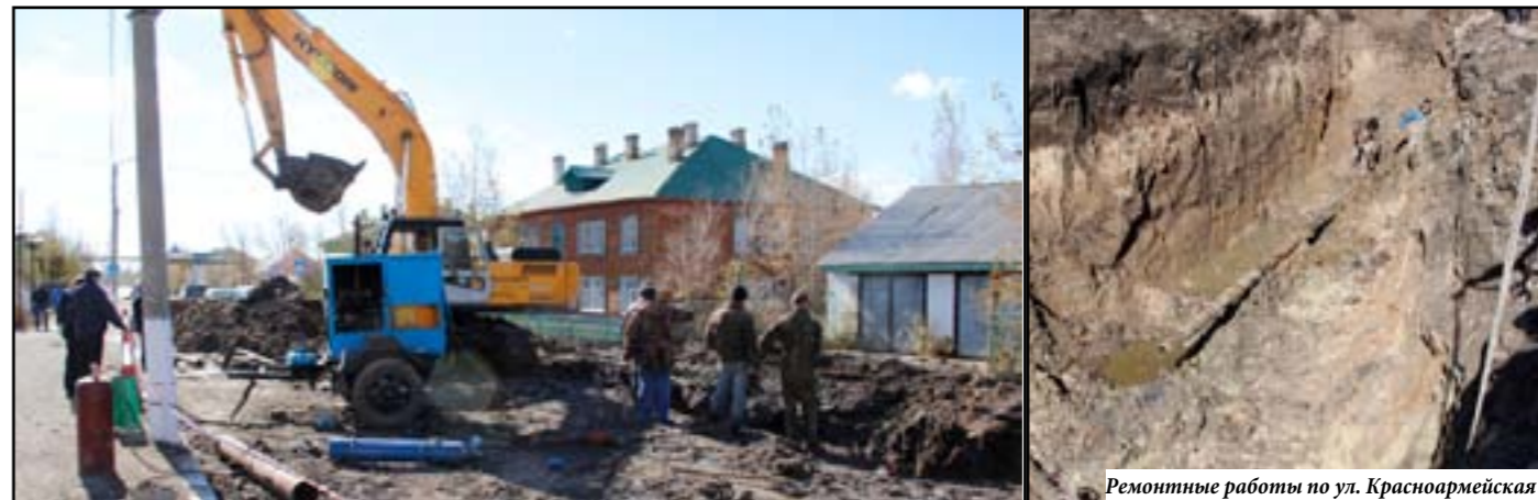
Ремонтные работы по ул. Красноармейская
